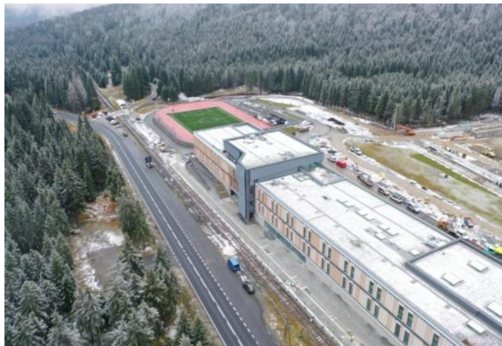
Polana Jakuszycka - Ośrodek Narciarstwa Biegowego i Biathlonu (w budowie / jesień 2021r.)
