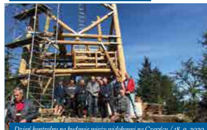
Dzień kontrolny na budowie wieży widokowej na Czernícu / 18. 9. 2020
