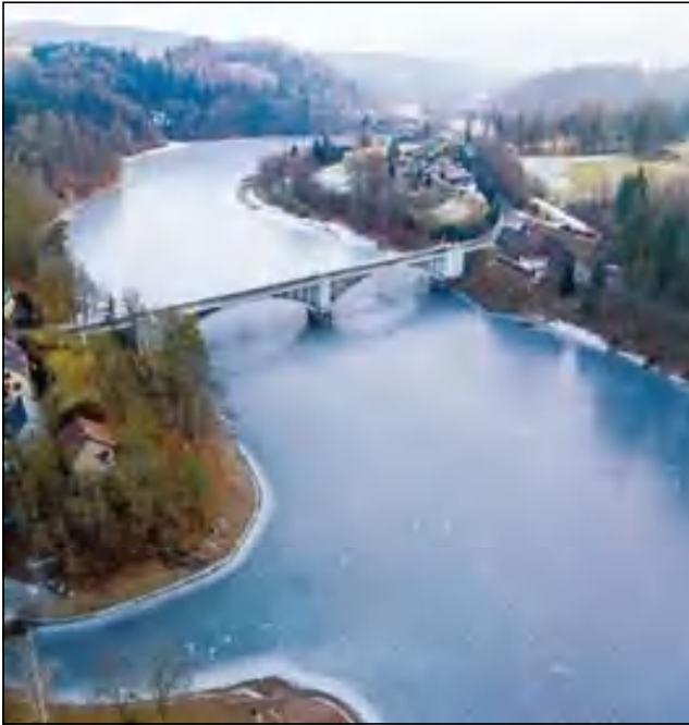
Železobetonový most přes přehradní nádrž Pastviny
