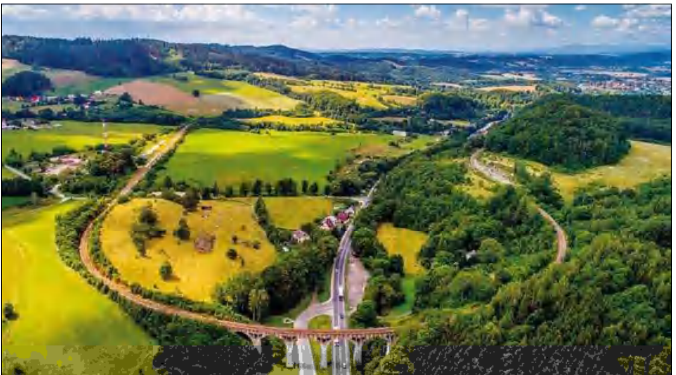
Železniční viadukt v obci Lewin Kłodzki
