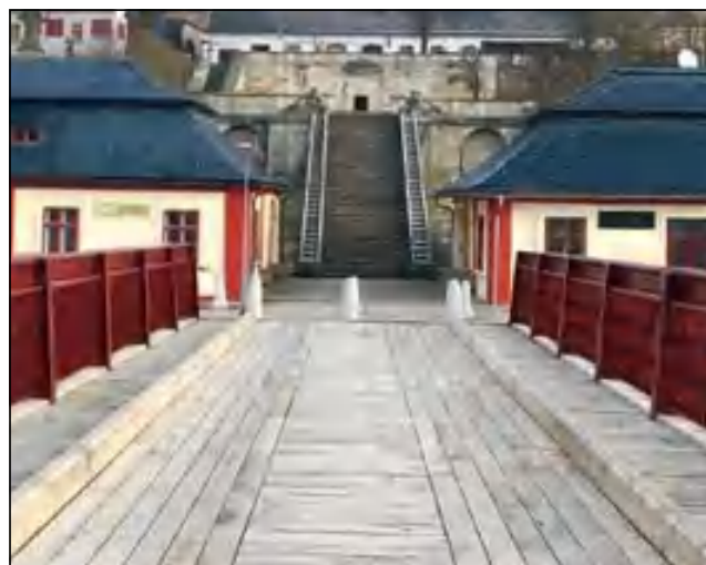
Ocelová část mostu v Kuksu po rekonstrukci
