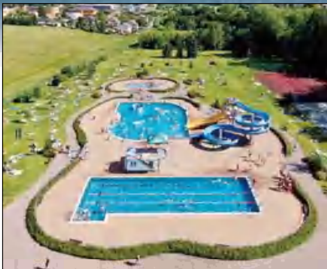
Bazén v Meziměstí
