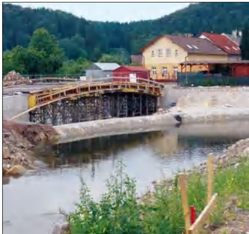
Budování regulace a nového mostu ve Velkém Poříčí
