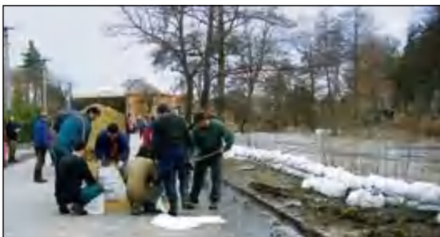
Budování protipovodňových zábran v roce 2006
