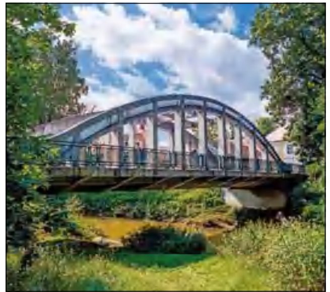
Most přes Tichou Orlici v Borohrádku
