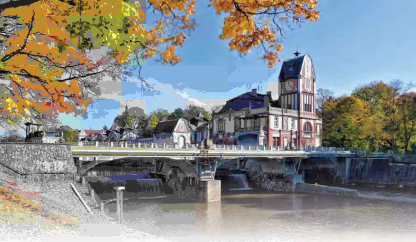
Elektrárna Hučák v Hradci Králové
