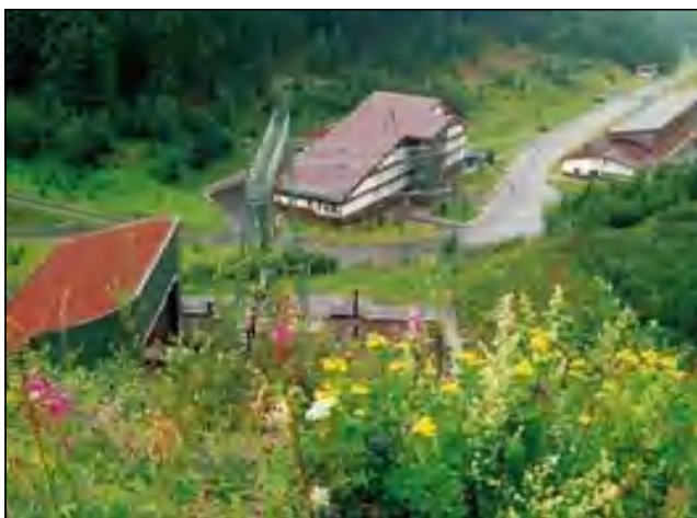
Trafostanice u dolní nádrže
