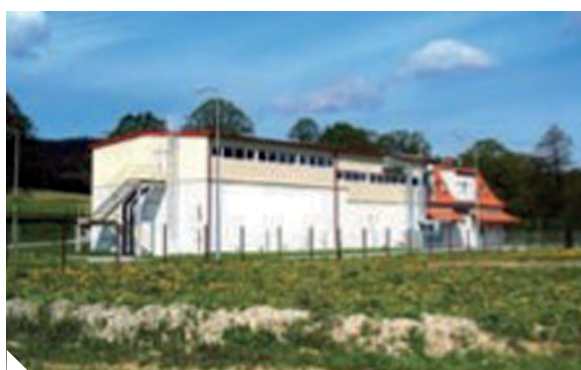
Oczyszczalnia w Międzyzlesiu
