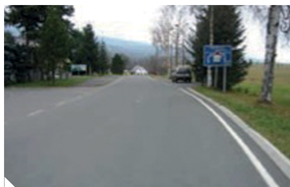
Orlické Záhoří – Modernizacja drogi II/311
