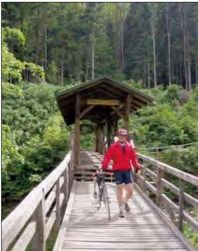
Mostek Boušinská lávka już kilka razy zerwała woda
