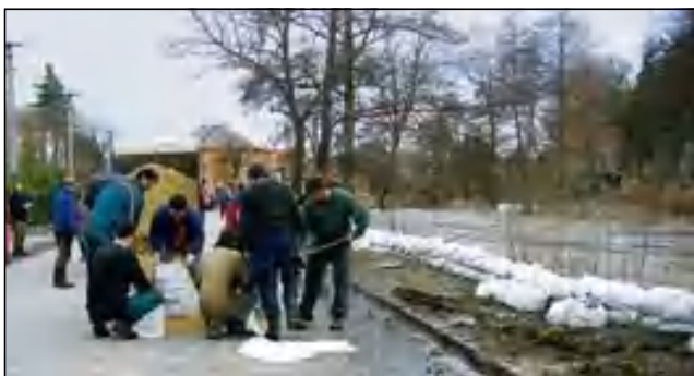
Budowanie barier przeciwpowodziowych w 2006 roku
