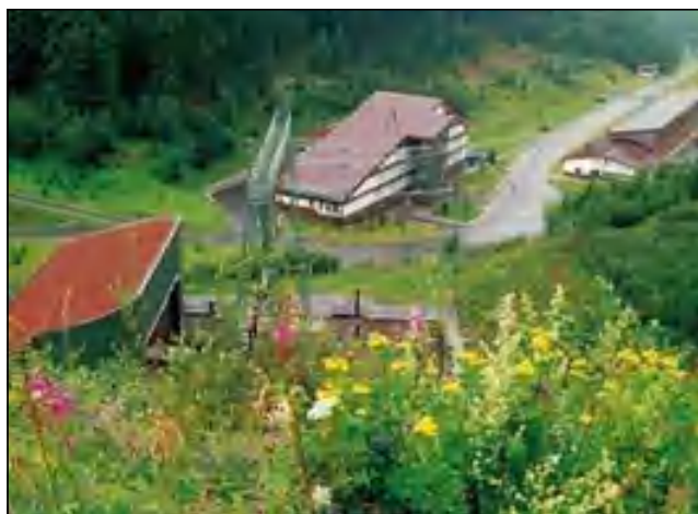
Stacja transformatorowa przy dolnym zbiorniku
