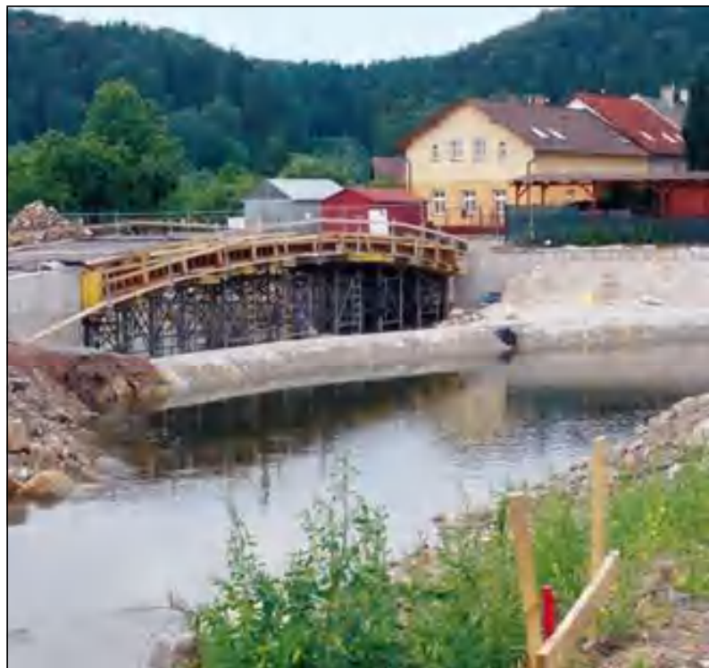
Budowanie regulacji i nowego mostu w miejscowości Velké Poříčí
