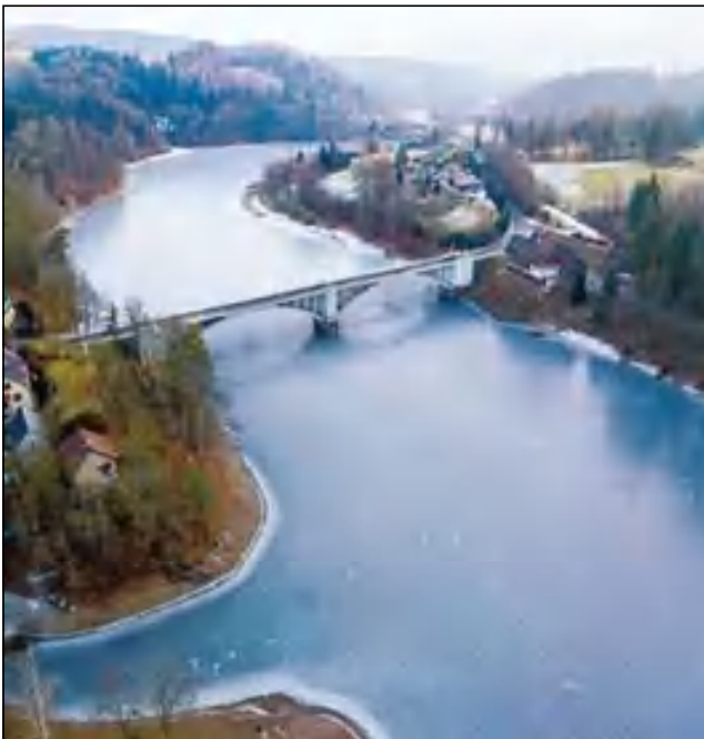
Żelbetowy most przez zaporę Pastviny
