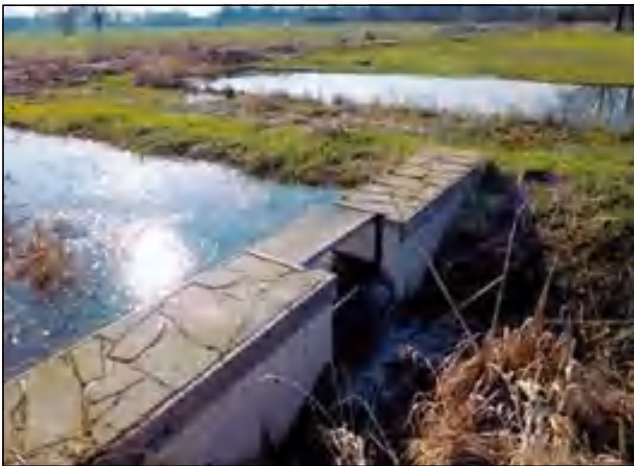
Zastawa na odnowionych kanałach
