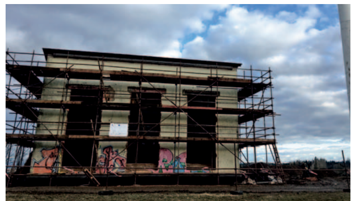
Budowa punktu informacyjnego turystycznego na Šibeníku w Novym Hrádku
