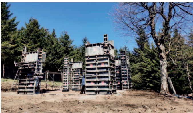
Budowa wieży widokowej na Orlicy
